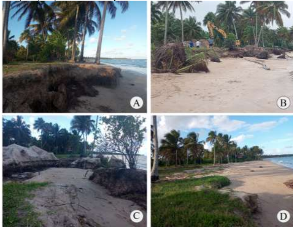
Figura 4 - Obra de contenção do mar na praia de Lages, Porto de Pedras - AL, utilizando-se da técnica “ Sand bag ” para evitar erosão marinha. (A) Antes. (B) Durante. (C-D) Depois da contenção do mar.
